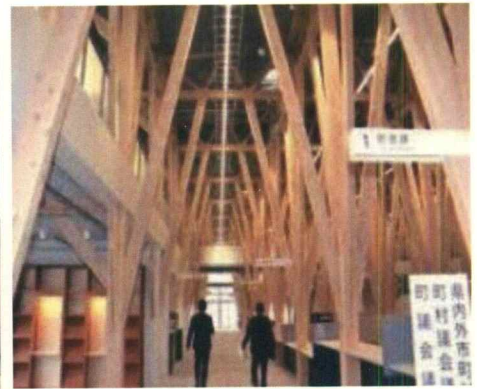
木造新庁舎の内部
