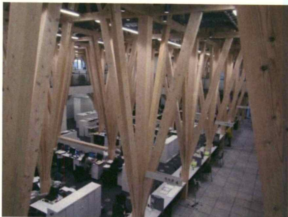
方杖筋違付き軸組工法
