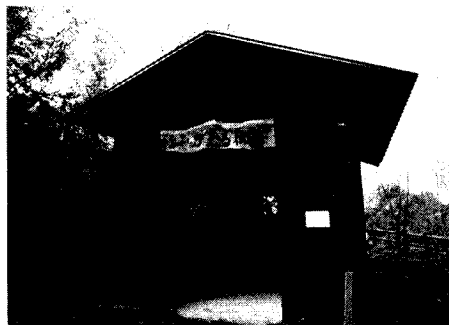
土石流等監視所
