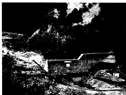
濁沢川復旧治山工事
