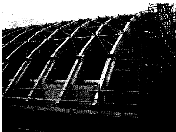
建設中の体育館。断面15センチ×24センチの木材を7段重ねた「錦帯橋」型のアーチ梁がほぼ完成(2010年7月撮影)
