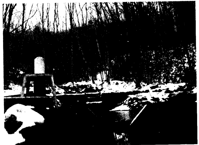
流量観測用の量水堰と水位計
